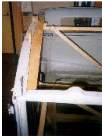
Tillverkning av mall för takbalk.
